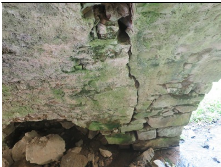
podhled zdiva klenbového pasu - levá strana nad opěrou 1
