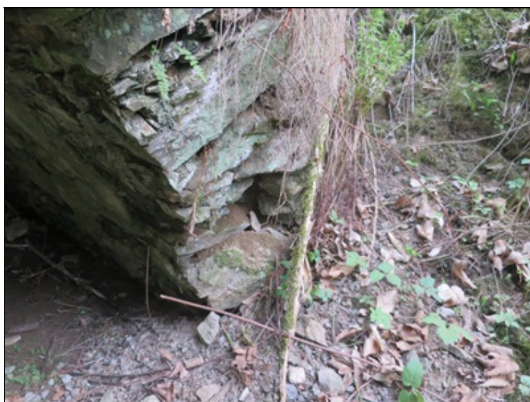
DTTO - detail pravého boku zdiva klenbového pasu nad opěrou 2
