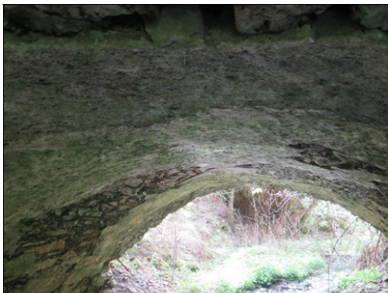
podhled zdiva klenbového pasu - příčný pohled zleva
