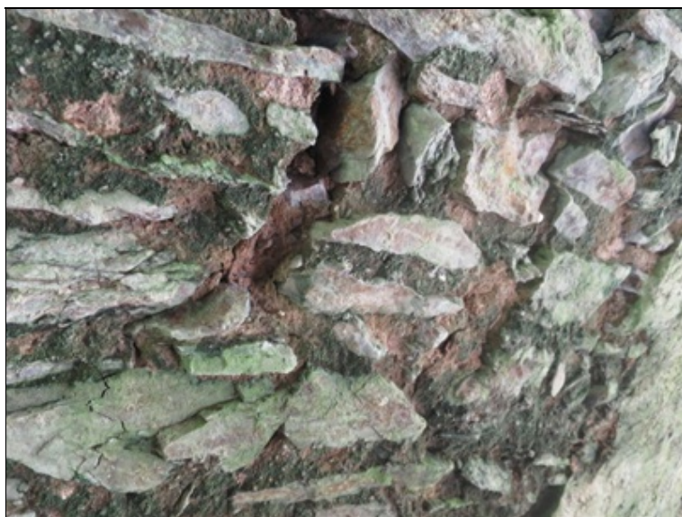
podhled zdiva klenbového pasu - střední část zdiva nad opěrou 2
