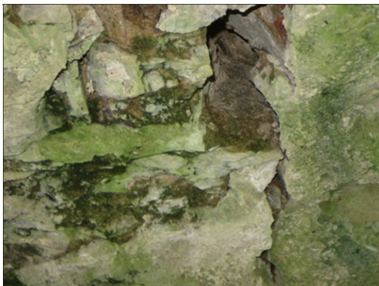
podhled zdiva klenbového pasu - detail podélné trhliny v pasu, která pravděpodobně kopíruje trajektorii rubu poprsní zdi
