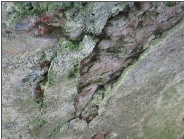
podhled zdiva klenbového pasu - drobnější poruchy v okolí podélné trhliny kopírující trajektorii rubu levé poprsní zdi
