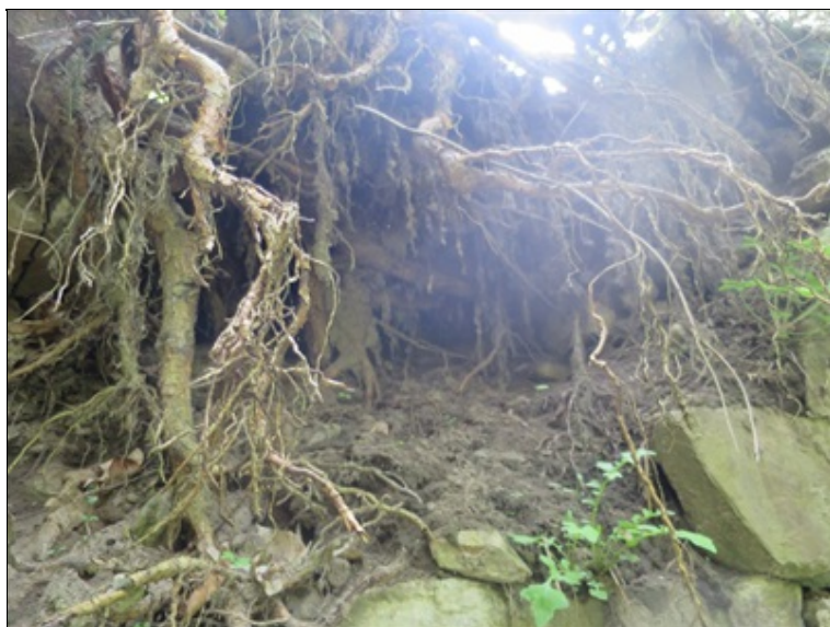
zdivo všech prvků mostu je poškozováno kořenovými systémy uchycených stromů
